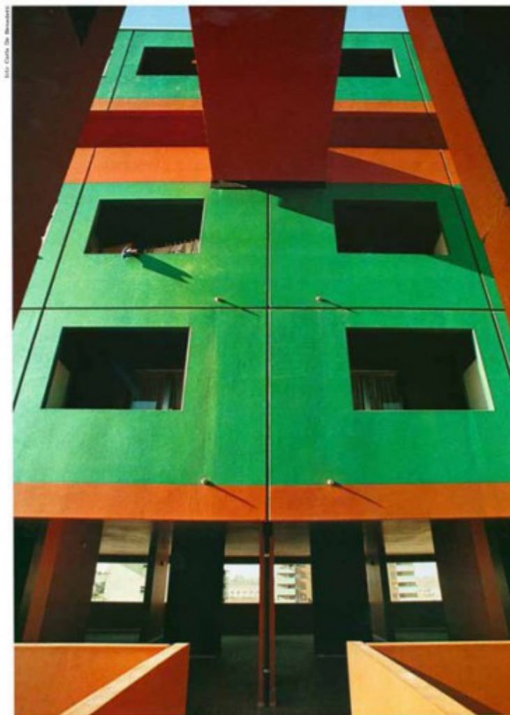
Le superfici esterne (pannelli) e griglia in spessi tubi dipinti con vernici acriliche.
